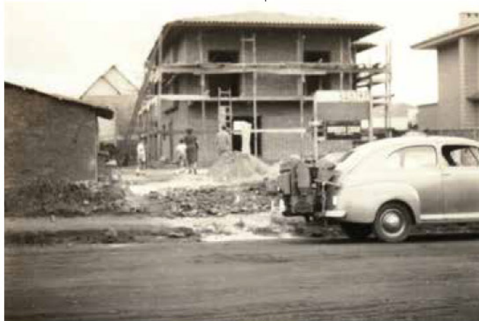
A construção da casa da Rua Fonseca Teles, e o "Cinza", com seu gasogênio Mercury, em primeiro plano
